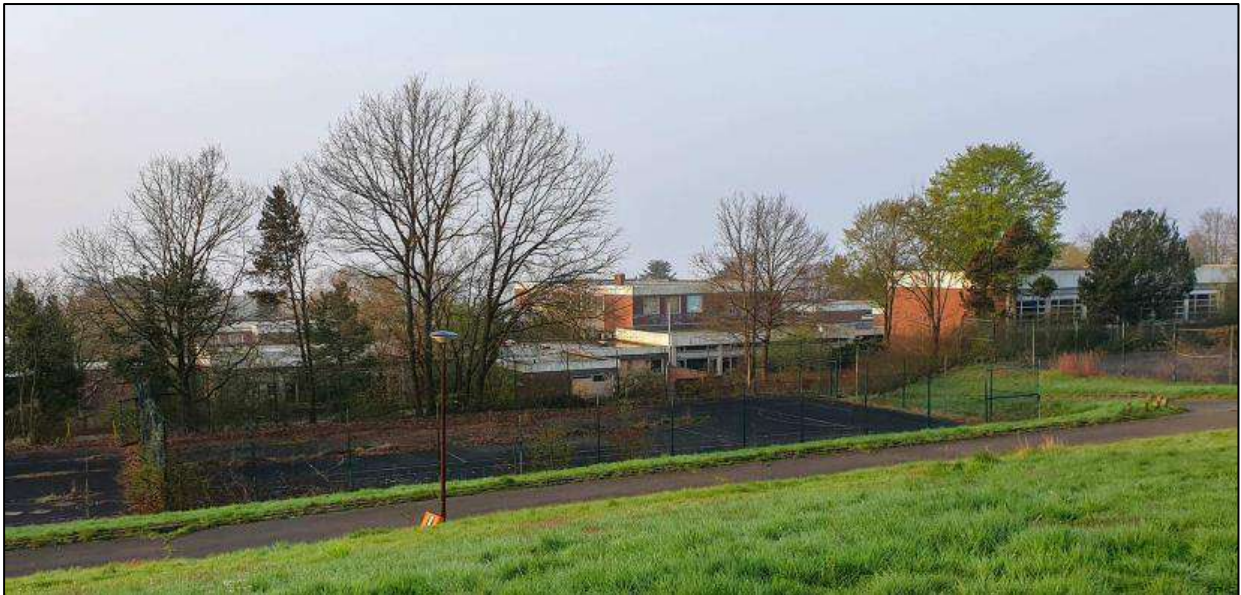
Blick über Gebäudekomplex und Sportplatzfläche der ehemaligen Prince-Ruppert-School (Foto Bohrer 2023).
