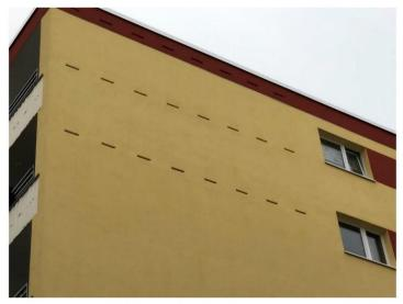
Umsetzungsbeispiel Nisthilfe für Fledermäuse (fassadenintegrierter Flachstein)
